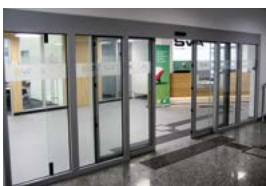
Automattür in St. Pölten
